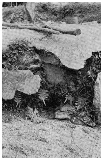
写真16 浸漬槽の側面にある排水孔
